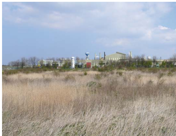
Oprukkende industrialisering van Delfzijl. Op de voorgrond het terrein waar de commanderij Oosterwierum gestaan heeft.
